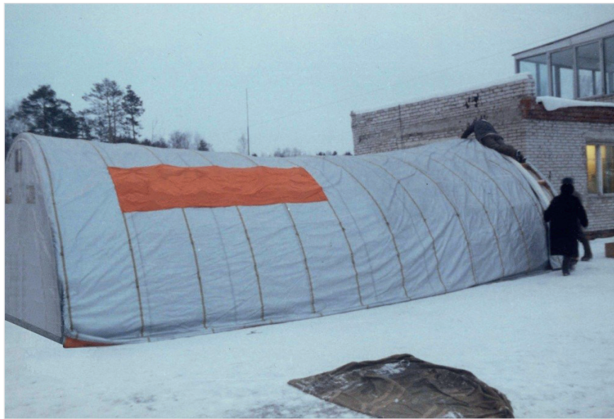
Рис. 3. Покрытие оболочки парашютной тканью
