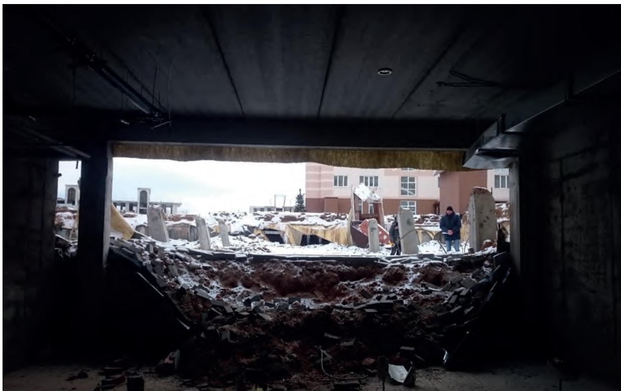
Рис. 3. Обрушение покрытия подземной парковки в г. Сергиев Посад, ул. Фестивальная
