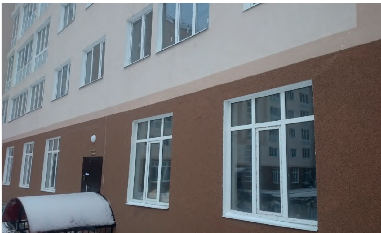
Рис. 2. Обрушение покрытия подземной парковки в г. Сергиев Посад, ул. Фестивальная. Повреждение фасадного покрытия жилого дома
