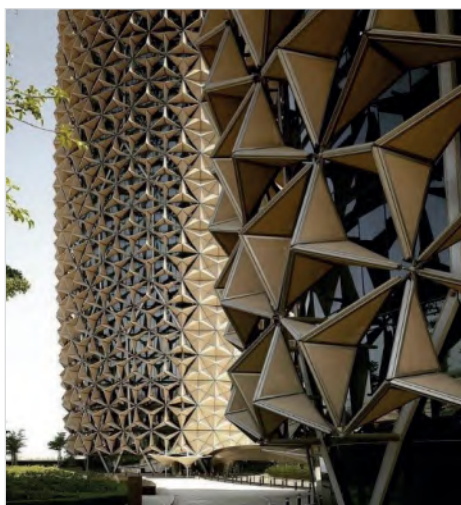
Рис. 7, 8. Динамическая фасадная система башен Аль Бахар
