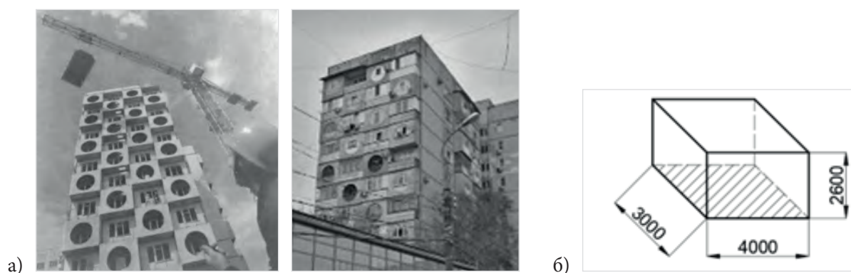
Рис. 1. Жилой дом серии БКР-2 в Краснодаре, ул. Трудовой Славы 10. 1979 г. п.: а) монтаж ячеек (слева) 3 , вид здания в 2023 году (справа) 4 ; б) типовая модульная ячейка для серии БКР-2: аксонометрия (габариты указаны в миллиметрах)
