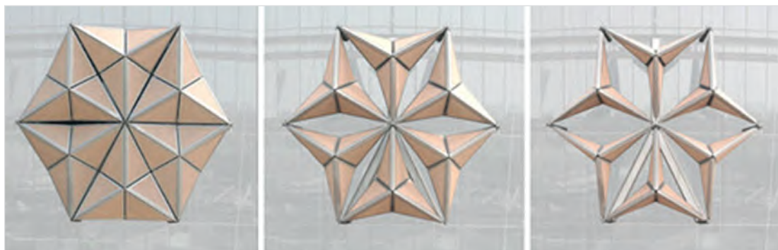
Рис. 9. Движение модулей фасада башен Аль Бахар
