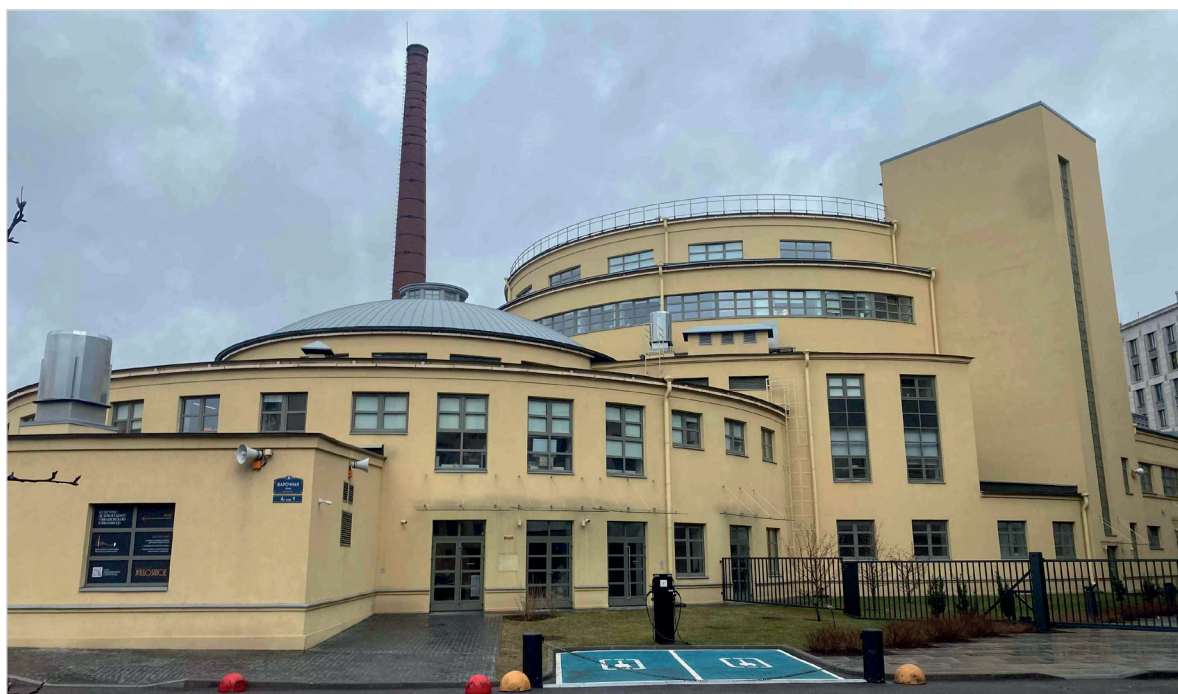
Рис. 3. Вид Левашовского хлебозавода после реконструкции
