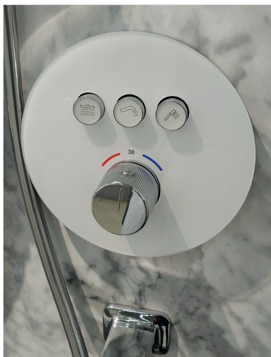
Рис. 1. Блок управления термостатическим смесителем в душевой кабине (автор фотографии доц. Орлов Е. В.)
