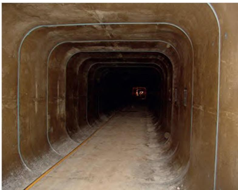
Рис. 2. Коллектор к Люберецким очистным сооружениям г. Москвы после реконструкции
