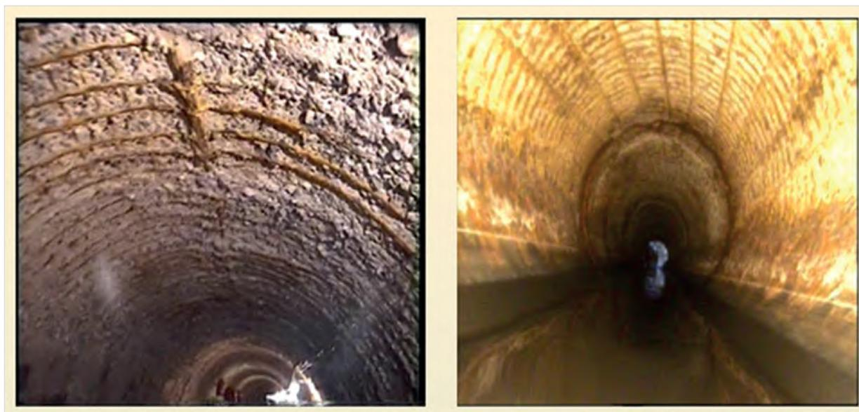
*Рис. 1.* Проявление последствий газовой коррозии железобетонного водоотводящего коллектора
